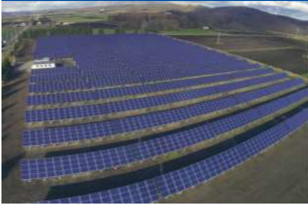
北海道 池田PV(2013) 最大出力 : 999.6kW
