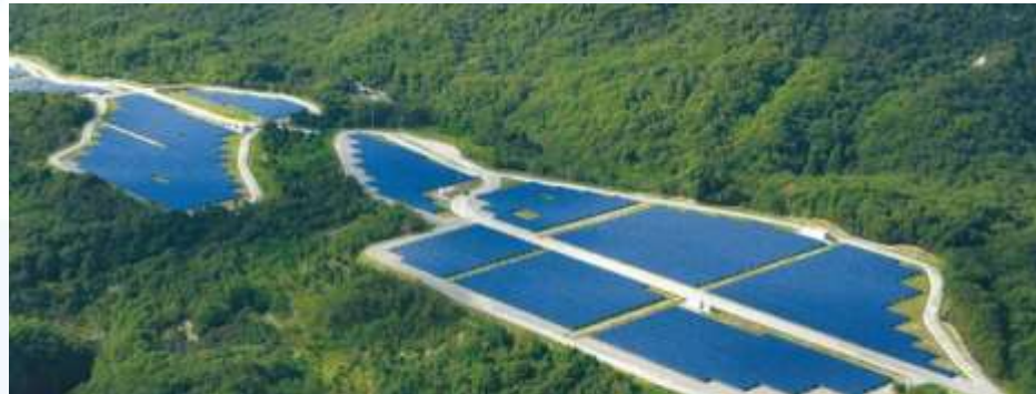
株式会社大林クリーンエネルギー兵庫県(2014) 最大出力：9,700kW
