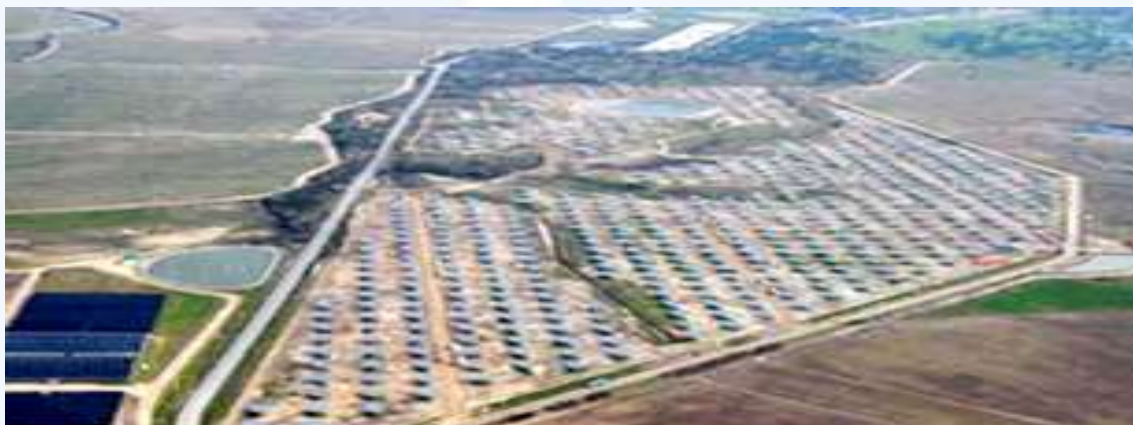
スペイン・Iberdrola Solar Park Caceres(2008) 最大出力：10MW
