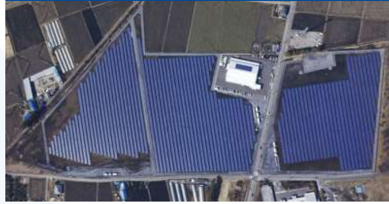
栃木県宇都宮市(2013) 最大出力 : 7,512kW
