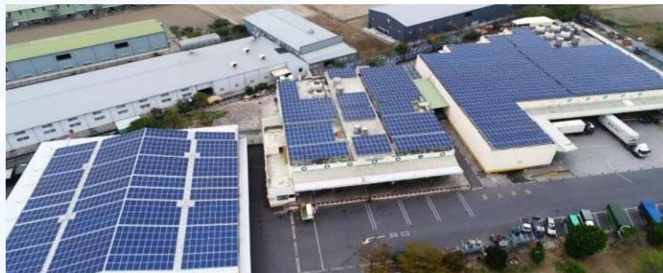
台南卸売市場(2017) 最大出力：2.32MW
