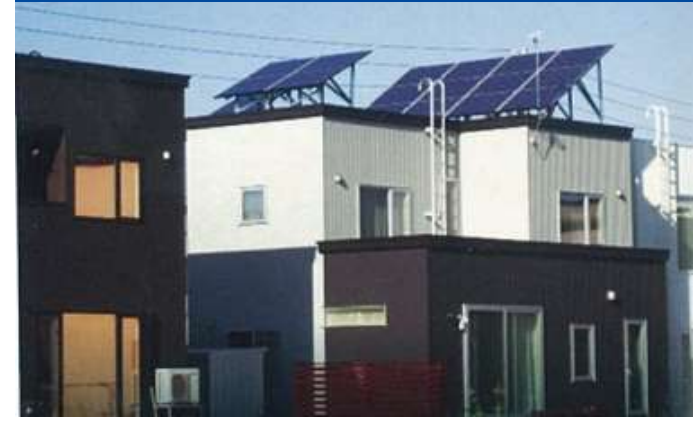
札幌市無落雪屋根(2011) 最大出力：3.78kW
