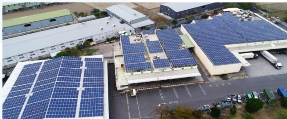
台南卸売市場(2017) 最大出力：2.32MW
